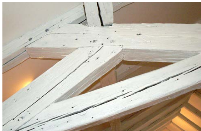
Realizace protipožárního nátěru FG500 FLAMGARD
