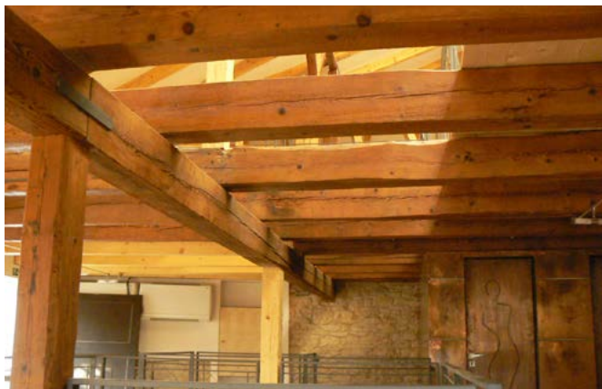
Realizace protipožárního nátěru FG700 FLAMGARD TRANSPARENT
