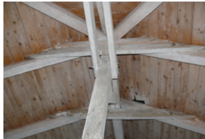
Realizace protipožárního nátěru FLAMGARD
