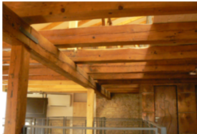
Realizace protipožárního nátěru FLAMGARD TRANSPARENT
